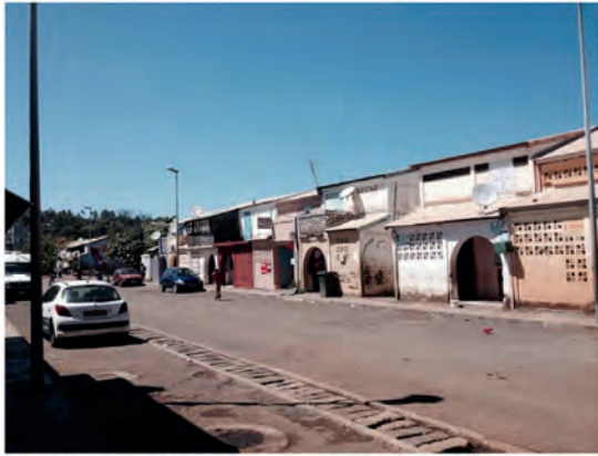
Cette photo a été prise dans le quartier de M'Gombani dans la commune de Mamoudzou. Elle montre comment était le quartier avant l'opération de rénovation urbaine et le type d'habitat qui y existait. Le caractère de délabrement avancé justifie l'opération d'aménagement (C. Remou, 2014).
